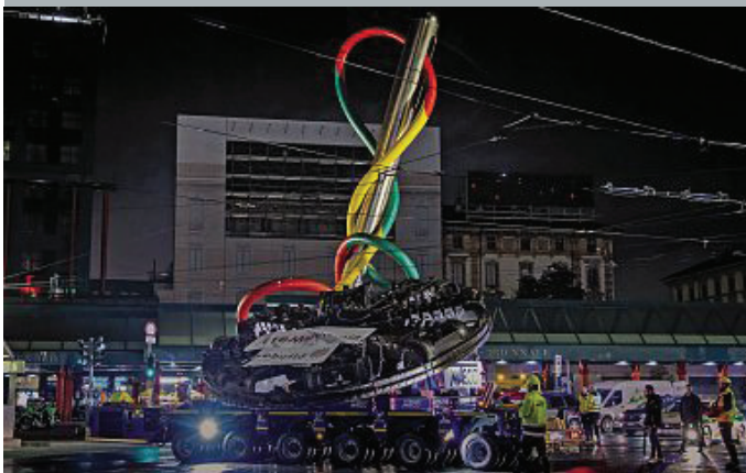
In Cadorna La testa della Talpa che ha scavato la galleria della M4 verso il Museo della Scienza (foto Rossella Papetti/Lapresse)
