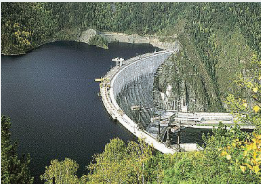
A maggio la produzione di energia idroelettrica è cresciuta del 33,5% su anno (nella foto una centrale)
