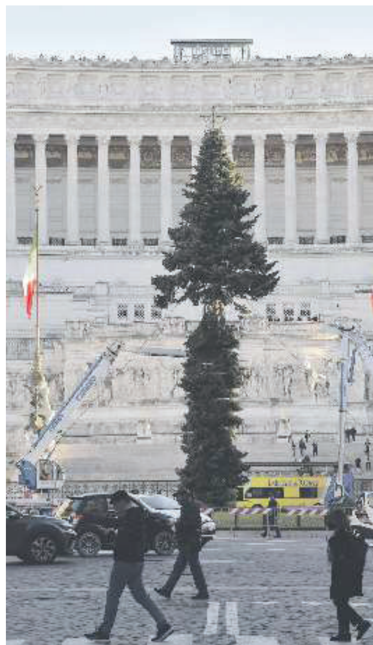
L'installazione dell'albero a piazza Venezia (foto LEONE/TOIATI)
