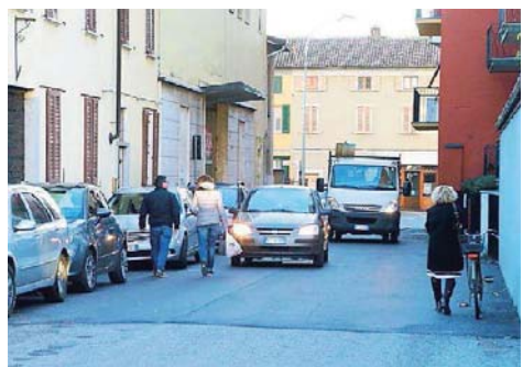
In via Parini sono già iniziati i lavori di asfaltatura
