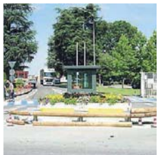
L'ingresso della raffineria
