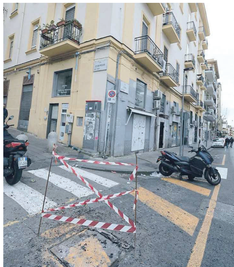
Via Solimena chiusa al traffico per il pericolo crollo di un edificio NeaPhoto Renato Esposito
