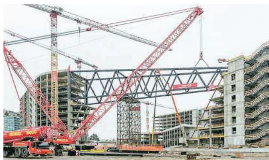
▲ an onato Il ponte c e collega i due edifici del centro ni alle porte di ilano
