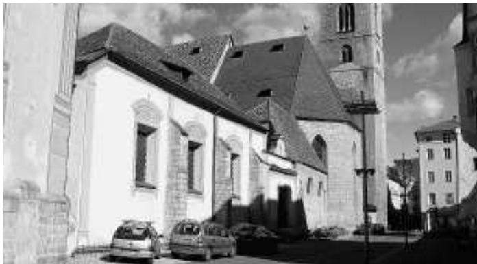
Molti immobili in via Albuino riportarono danni a causa degli scavi per la posa del nuovo collettore
