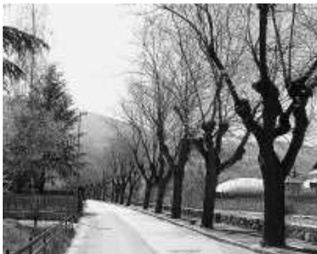
Da lunedì al via i lavori per il teleriscaldamento in via Battisti
