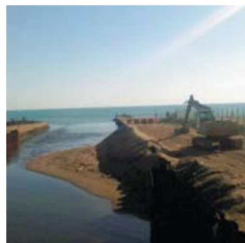
Scavi Ruspe in azione nel canale
