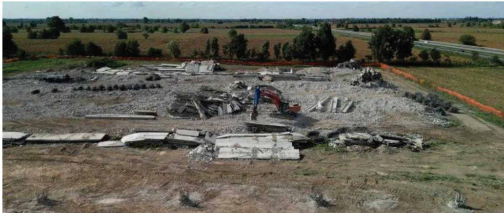
Quel che resta dell'ecomostro di San Gervasio demolito: le macerie del relitto del centro commerciale saranno triturate e utilizzate come materia prima per la costruzione del polo logistico
