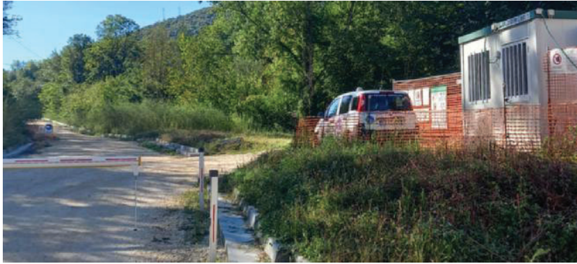
Il cantiere Terna di Fondi di Agnosine dove sabato notte si è verificata l'assurda tragedia costata la vita alla guardia giurata 51enne
