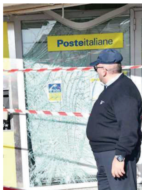
Un metronotte del Corpo dei vigili giurati osserva i danni causati al postamat e all'ufficio
