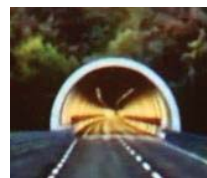
L'imbocco del futuro traforo
