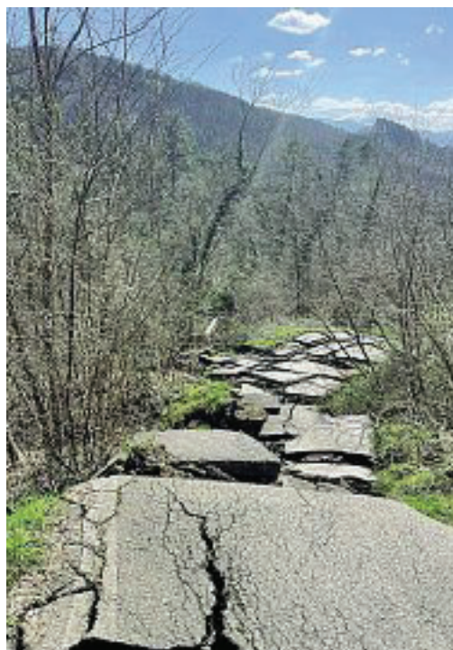
Crollo La strada che porta alle frazioni di Marzano e Volpinaia distrutta dalla frana
