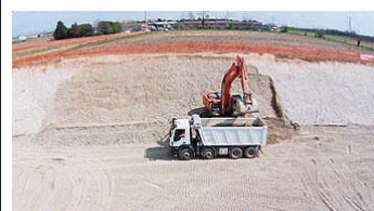
Il cantiere della Pedemontana a San Vito d'Altivole
