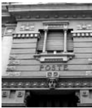
Le Poste centrali
