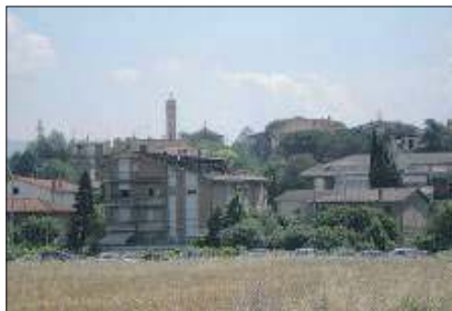
Passo Corese Ennesima denuncia dei lavoratori dell'istituto di vigilanza privata di via Ternana
