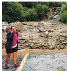
Lo strazio La frana sulla strada
