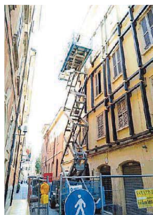
I lavori in via Blasìa
