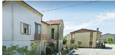
La zona di Curtarolo dove sono stati esplosi i colpi in aria
