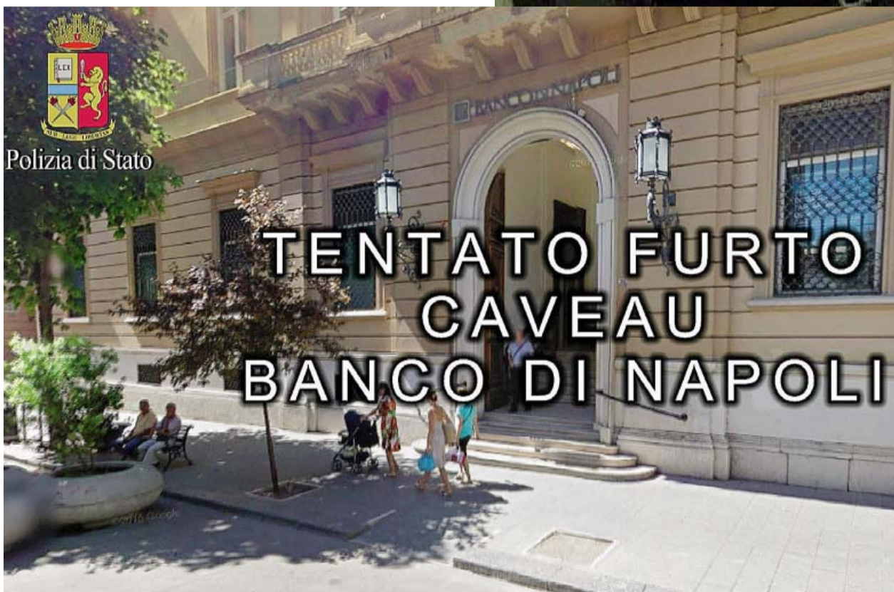
L'ISTITUTO DI CREDITO Il Banco di Napoli nell'isola pedonale, il tentativo di entrare dall'ingresso laterale. I filmati delle telecamere acquisiti dalle Forze dell'Ordine nelle indagini.
