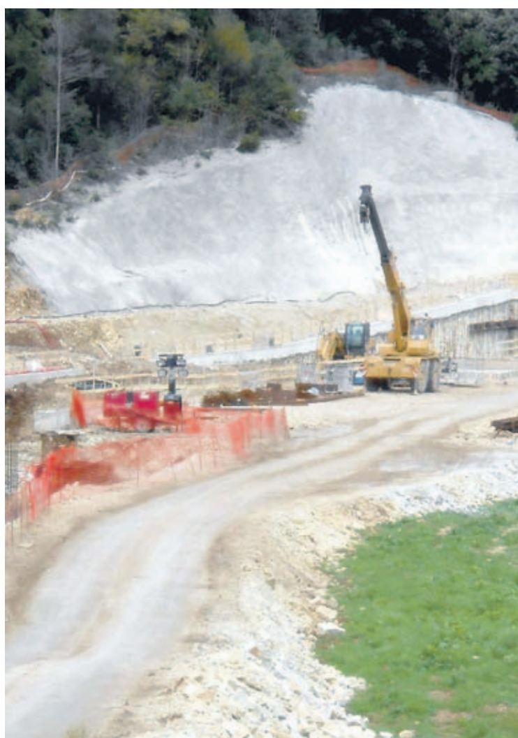
I lavori al cantiere di Piè di Moggio della Rieti-Terni
